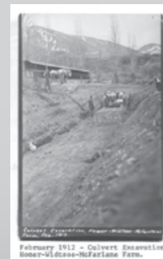
Weber-Provo Diversion & Canal
